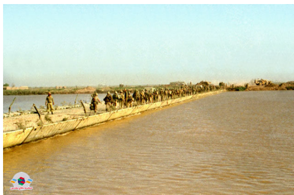
رزمندگان اسلام در حال عبور از یکی از پل‌های نصب شده
